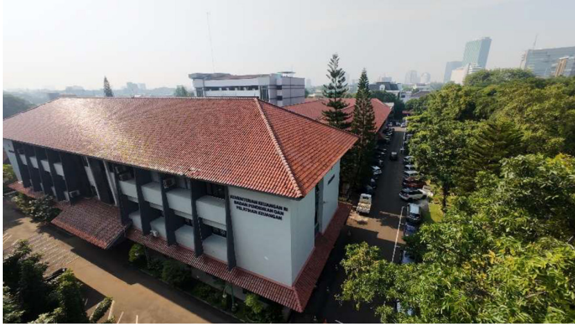
Gedung Kantor Pusat BPPK di Jalan Purnawarman Nomor 99, Jakarta.
